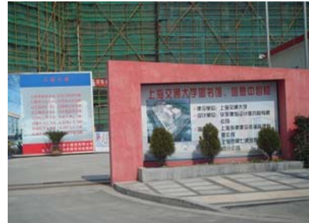
図書館新築中(2010年完成)
